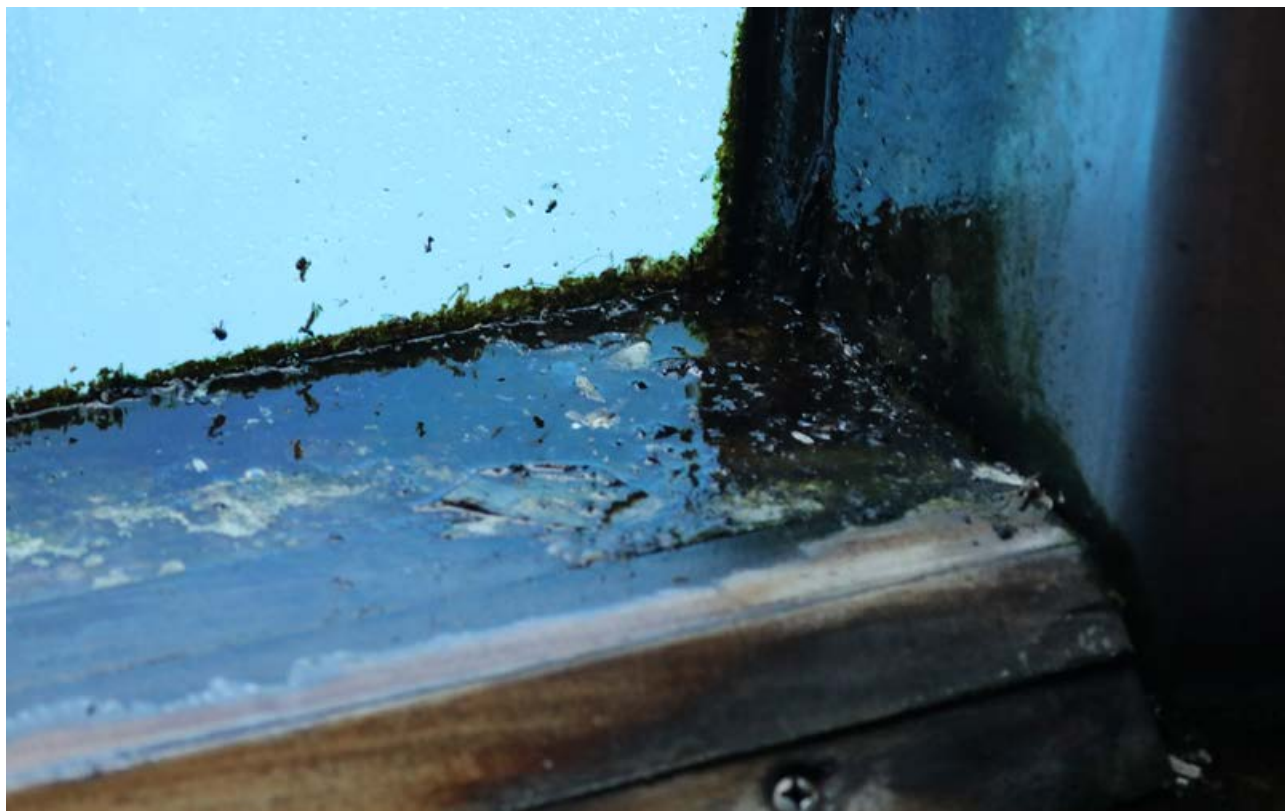
Illustration 44. L'une des nombreuses fuites dans les zones d'observation sous-marine de MarineLand, notez l'accumulation d'algues et d'autres débris. Cette zone n'a clairement pas été nettoyée depuis un certain temps. Photo fournie par One Voice (prise le 8 octobre 2021).
