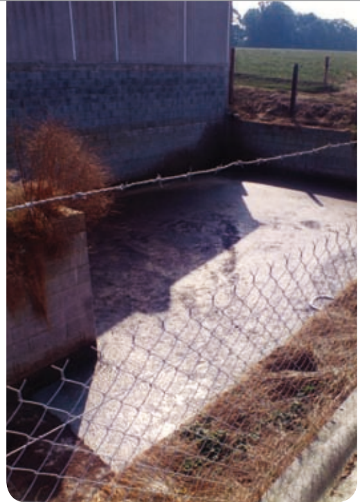
Une fosse à lisier en Bretagne...
